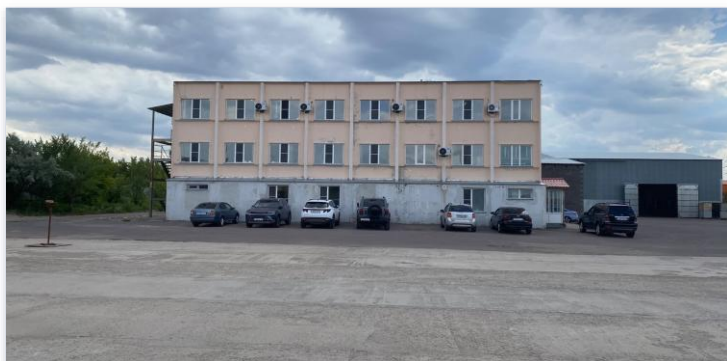
Цех металлоконструкций и АБК
