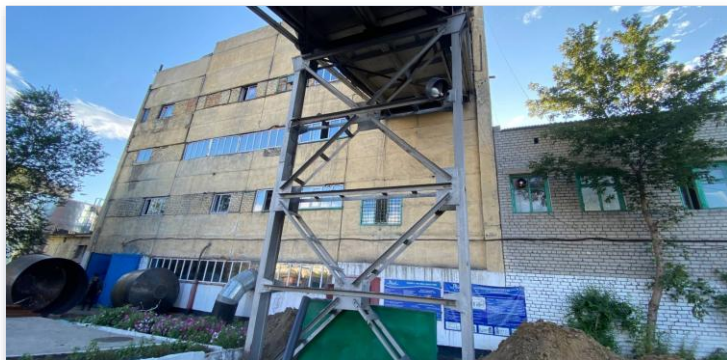
Здание котельной «103А»
