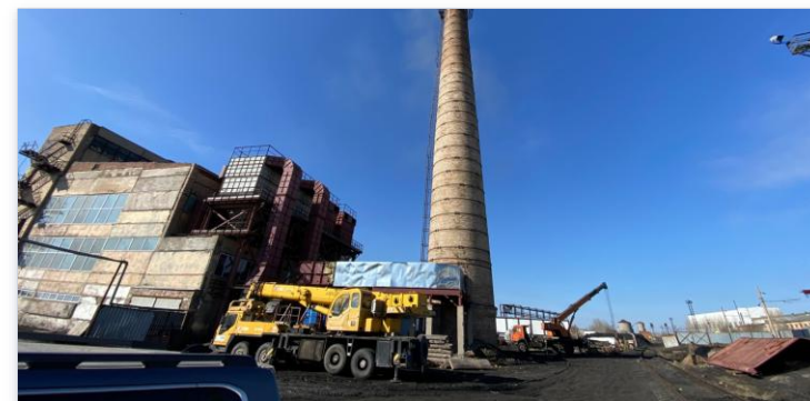
Труба центральной котельной
