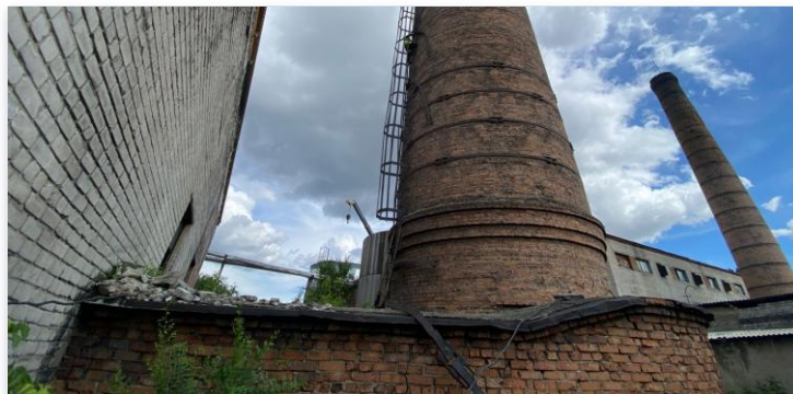
Труба котельной «103А»
