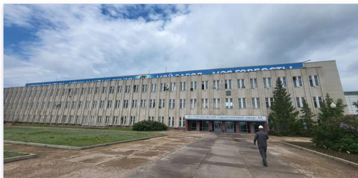
Кровля корпуса АО «СТПЗ»
